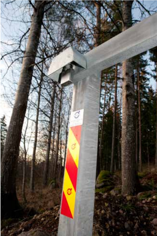
Låsanordningen är väl skyddad mot regn, snö och åverkan.
